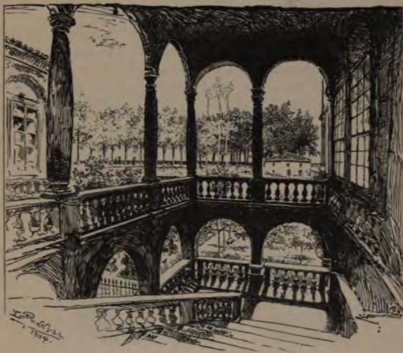
A STAIRWAY, LUCCA.
